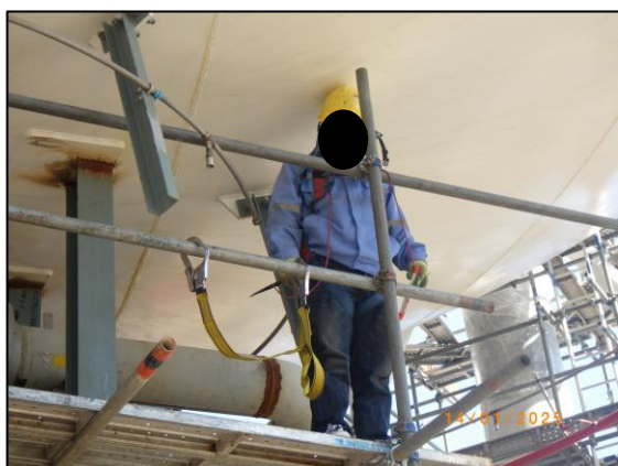
รูปที่ 2-60 การสวมใส่เข็มขัดนิรภัยสำหรับการทำงานบนที่สูง
