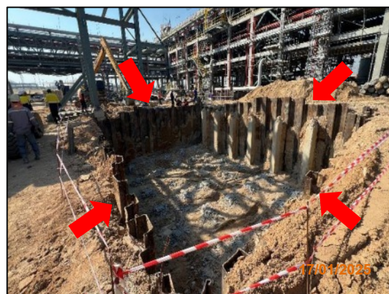
รูปที่ 2-66 กำแพงกันดินแบบเสาเข็มพืด (Sheet Pile Walls)
