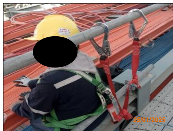
รูปที่ 2-60 การสวมใส่เข็มขัดนิรภัยสำหรับการทำงานบนที่สูง
