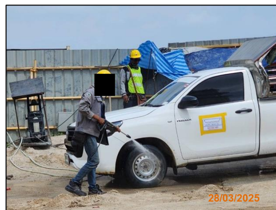
รูปที่ 2-6 พื้นที่ล้างล้อสำหรับรถที่ออกจากโครงการ
