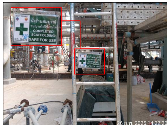
รูปที่ 2-61 การตรวจสอบสภาพนั่งร้านก่อนใช้งาน
