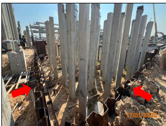
รูปที่ 2-66 กำแพงกันดินแบบเสาเข็มพืด (Sheet Pile Walls)
